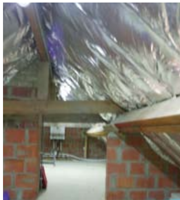
Onder de zoldervloer ligt 6 cm isolatiemateriaal, tussen het onderdak en de kepers 12 cm.
