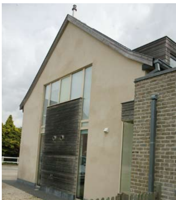
In de zijgevel kwam een lichtpartij met daarvoor een gevelbekleding in hittebehandeld hout, grenen dat door middel van een speciale behandeling een hoge duurzaamheid bezit.
